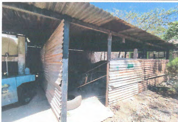
Foto 3: Mejoramiento de área de cocina
